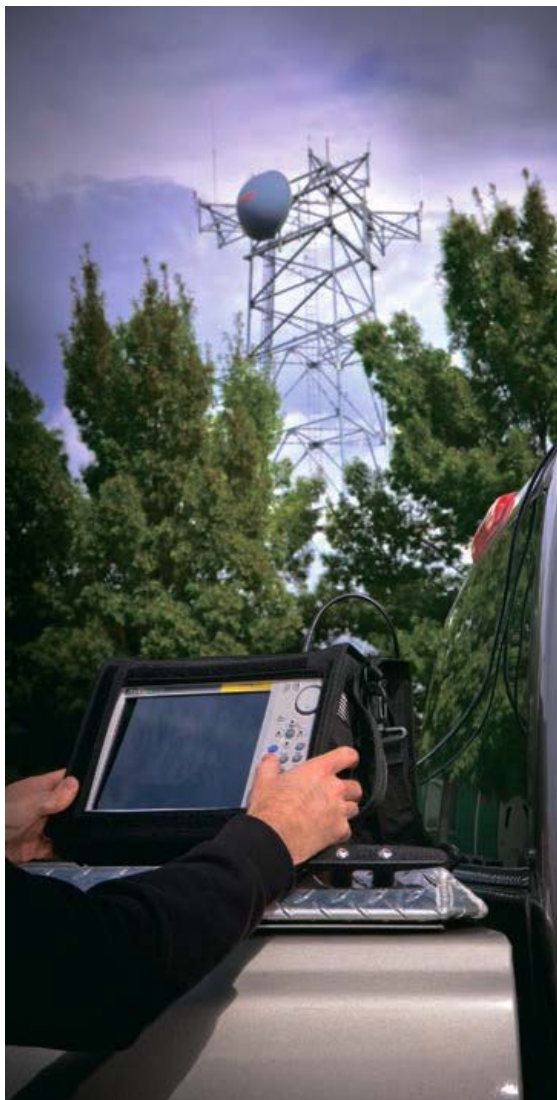
Тестирование с использованием анализатора LMR Master в машине технического обслуживания
